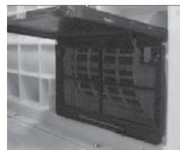
Ilustración B – Extracción del filtro de ventilación
